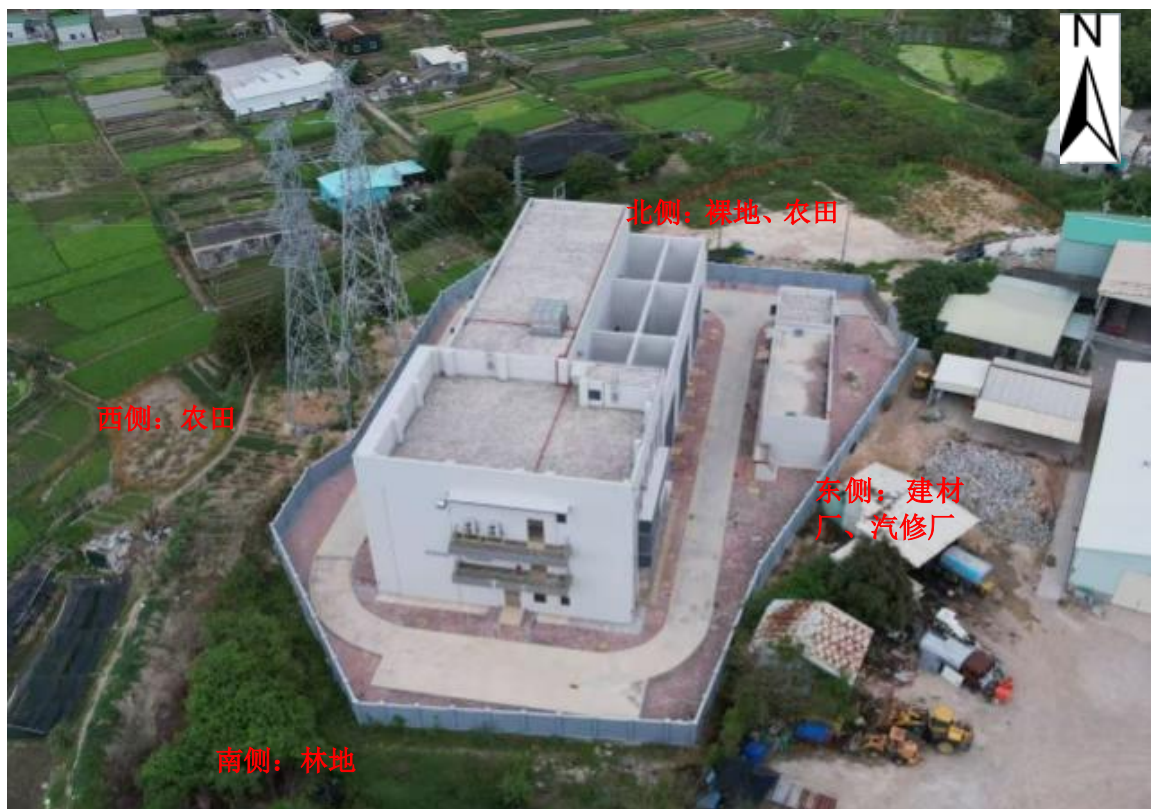
图 2-2 110kV 路南（碧春）变电站站址现状图
