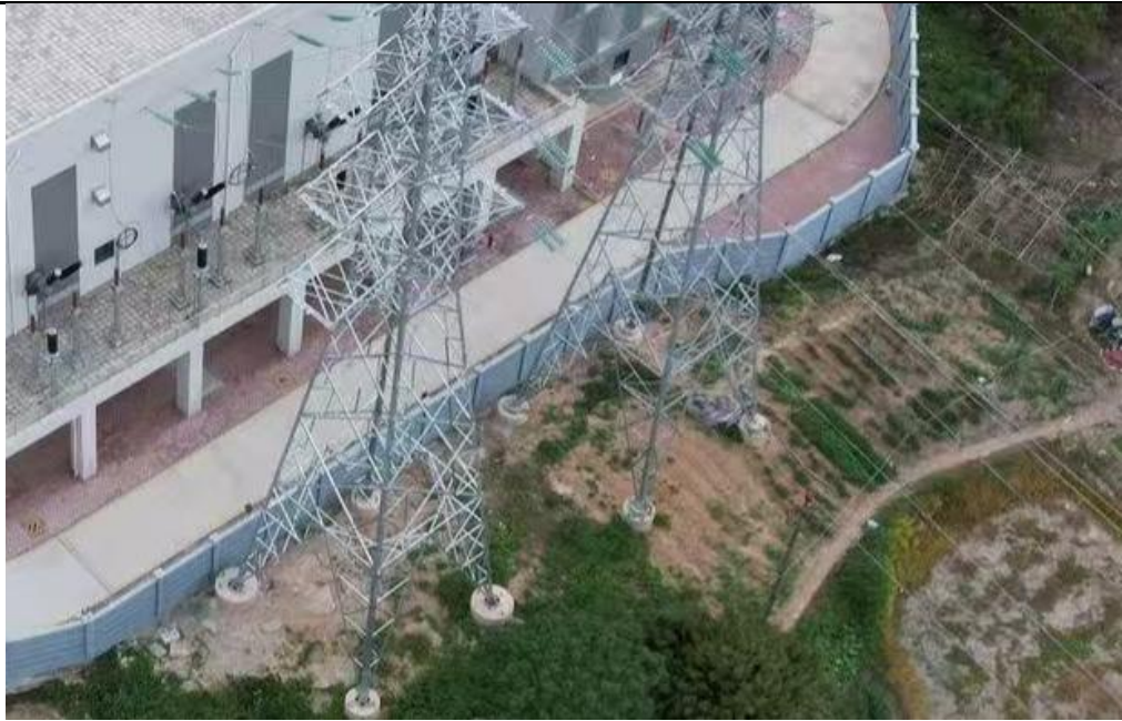
架空线路涉及植被的塔基周边绿化恢复情况
