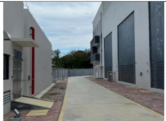
站内硬化道路
