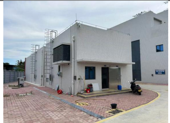
消防泵房及消防水池
