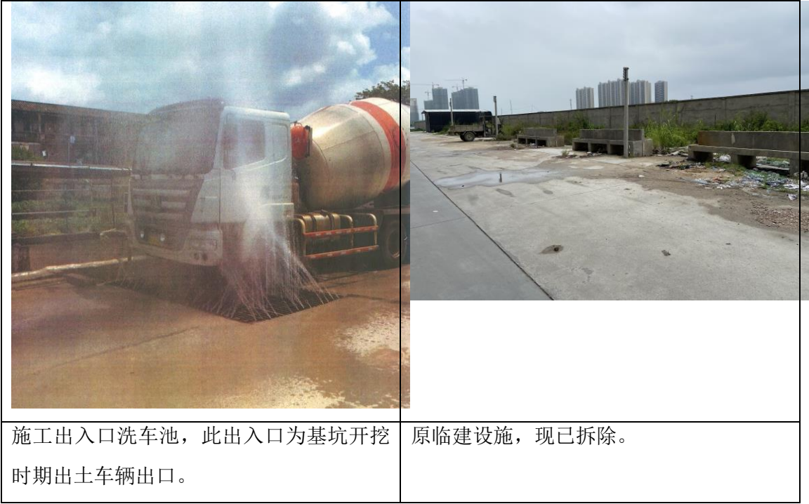
图 2-2 施工期及现状图
